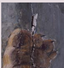
CADUTE DI FRAMMENTI DI INTONACO (9)
