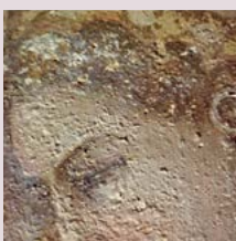
MANCANZE DI ADESIONE DELLA PELLICOLA PITTORICA (13 a-b)
