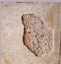
CADUTE DI FRAMMENTI DI INTONACO (9)
