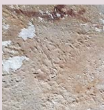
MANCANZE DI ADESIONE DELLA PELLICOLA PITTORICA (13 a-b)
