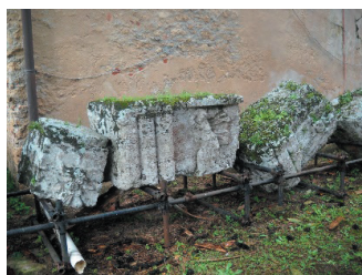
Stato di conservazione delle metope prima dell'intervento. La struttura in tubi e giunti su cui erano poggiati i blocchi presentava gravi dissesti
