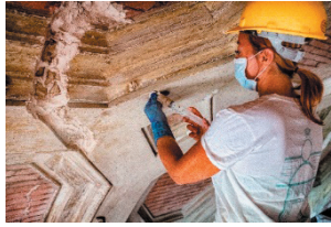
Reggia di Caserta Consolidamento dell'intonaco delle volte degli androni del Palazzo Reale – Reggia di Caserta Credits Marianna Tizzani
